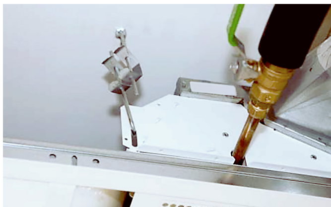
Bild 2. Montage med undertakskrok.
